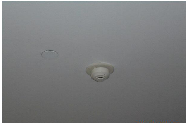
รูปที่ 29 เครื่องตรวจจับความร้อน (HEAT DETECTOR)
