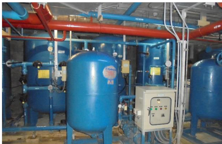
รูปที่ 12 ถังเก็บน้ำสำรองชั้นใต้ดิน
