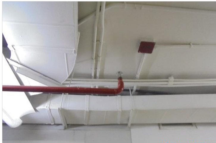
รูปที่ 23 ระบบดับเพลิงอัตโนมัติ (SPRINKLER SYSTEM)
