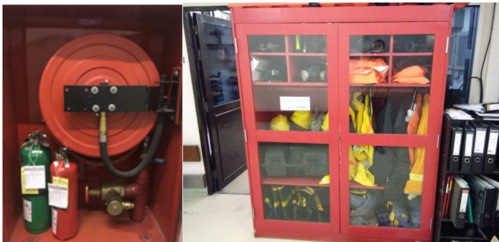
สายฉีดน้ำดับเพลิงและตู้เก็บสายฉีดน้ำดับเพลิง มีสภาพพร้อมใช้งาน
