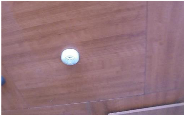
รูปที่ 28 เครื่องตรวจจับควัน (SMOKE DETECTOR)
