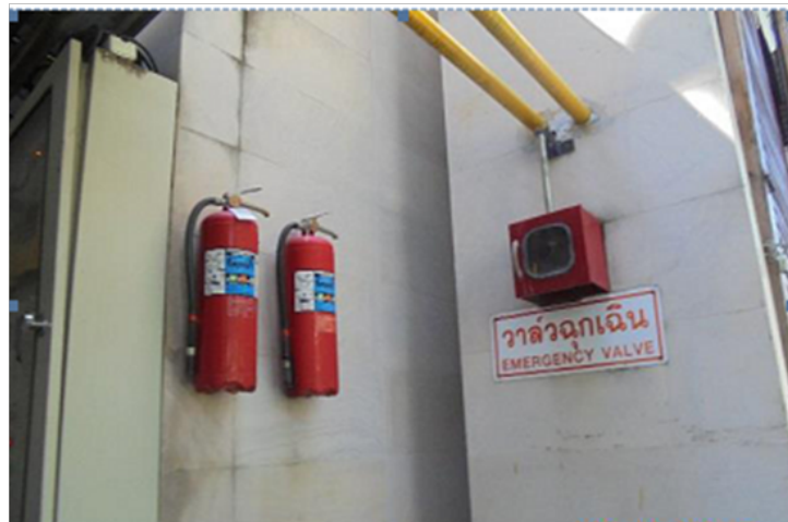
รูปที่ 22 ถังดับเพลิงเคมีแบบมือถือ
