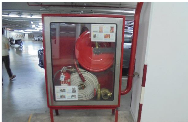
รูปที่ 21 ตู้สายฉีดน้ำดับเพลิงพร้อมอุปกรณ์
