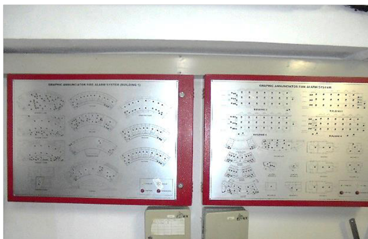
รูปที่ 27 FIRE ALARM CONTROL PANEL: FCP
