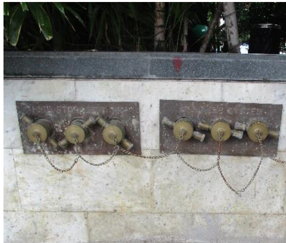
รูปที่ 31 หัวรับน้ำดับเพลิงภายนอกอาคาร
