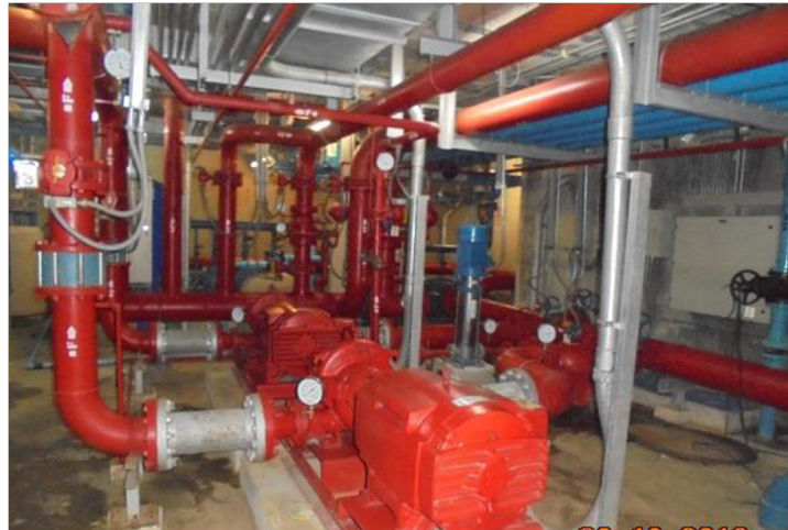
รูปที่ 20 ระบบป้องกันอัคคีภัย ท่อยืน (STAND PIPE) และเครื่องสูบน้ำดับเพลิง (FIRE PUMP)
