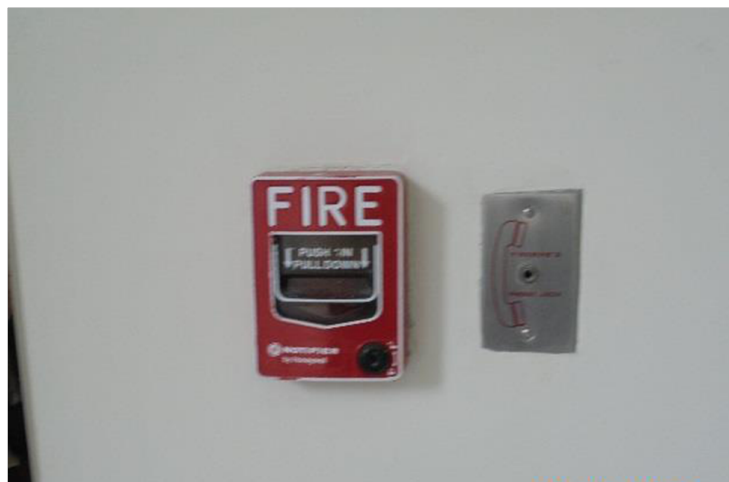
รูปที่ 30 เครื่องแจ้งเหตุโดยใช่มือดึง (MANUAL STATION)
